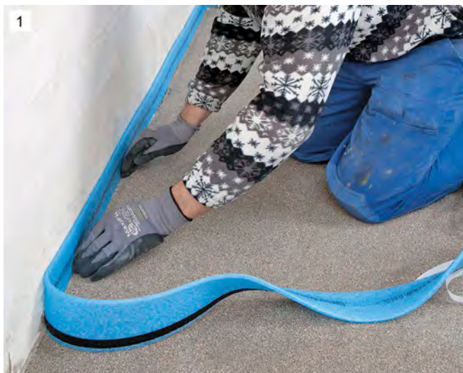
1) Uponor Multi liimikihiga ääreriba tuleb paigaldada kõikide seinte ja muude vertikaalsete pidadele ilma katkestusteta.
